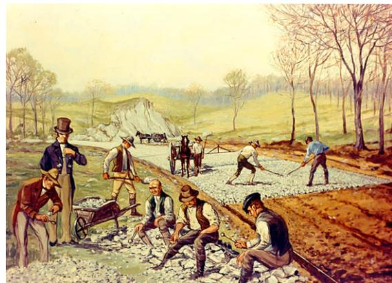
Abbildung 11: Straßenbau nach dem System Makadam ca. 1840: im Vordergrund das Planum mit den gesetzten Bordsteinen, dann der Grand (Schotterschicht), im Hintergrund die Sandabdeckung mit der Setzwaage. Im Vordergrund die Steinhauer für den Grand, Vorarbeiter und Ingenieur. Im Mittelgrund die Planeurs und ein Fuhrwerk für
