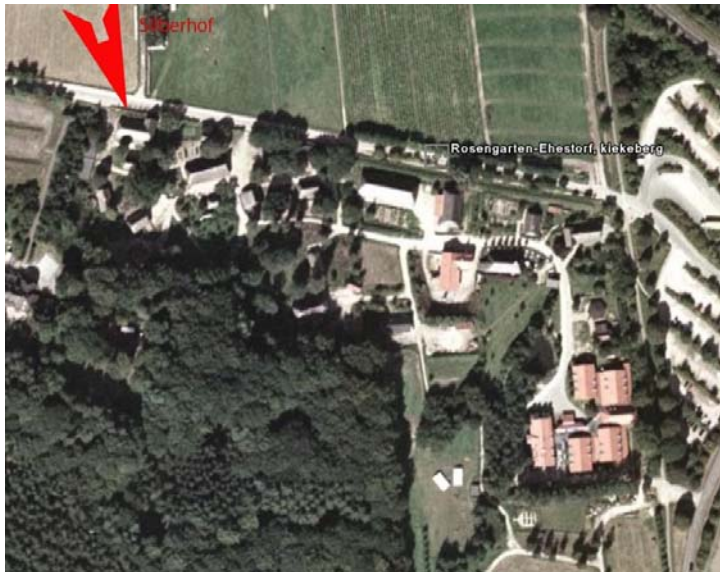
Abbildung 1: Luftaufnahme des Museumsgeländes
